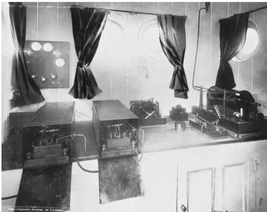
Fig. 67 - Cabina radio installata a bordo del piroscafo *Lucania*, in cui nel 1903 Marconi riceve messaggi da Poldhu e da Cape Cod che sono stampati sul "radiogiornale" di bordo.
