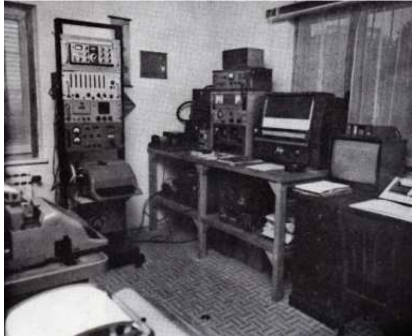
Rack controllo spettrografico UHF-e VHF
