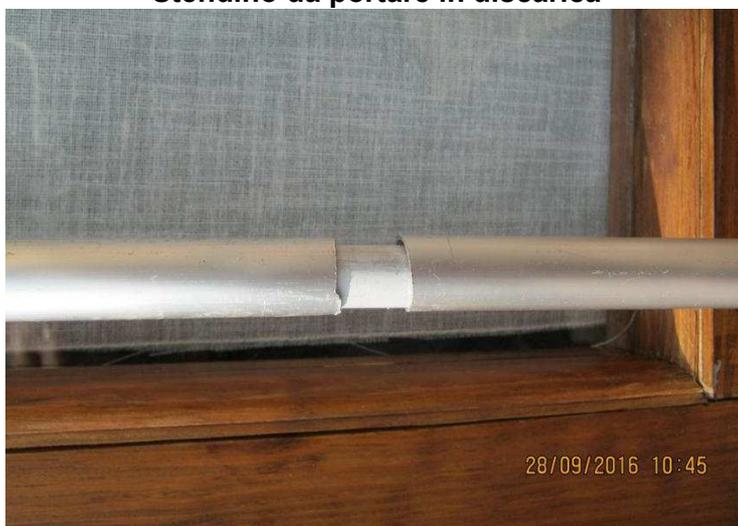
Tagliato il tubo e infilato un tubo di plastica per protezione
