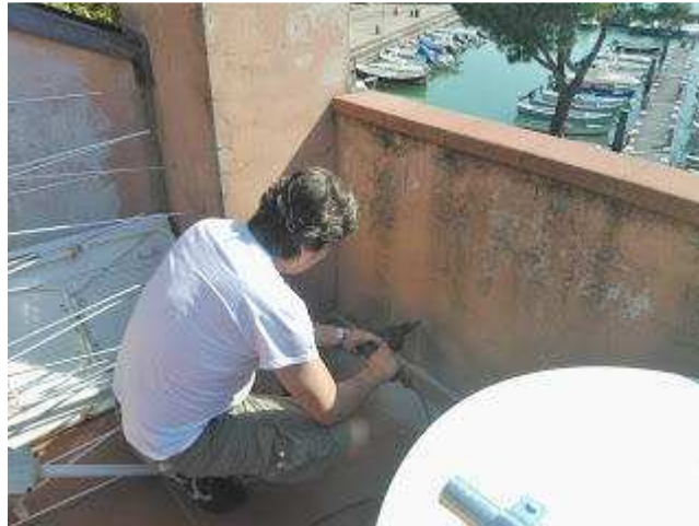
Lavori al via. Di trapano
