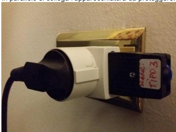
Ecco lo scaricatore di sovratensione accoppiato alla presa tripla, dove è collegato il frigorifero da proteggere. Resta ancora un posto elettrico libero, nella presa tripla per proteggere altro apparecchio.
