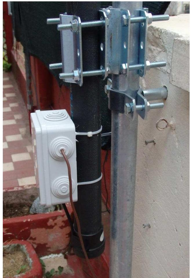
Scatola di protezione contenente il balun , a SX l'ingresso dei 4 radiali da 10m, posti a ventaglio . A DX il filo di rame è stato inserito all'interno della canna (filo da 2mm di 10mt.)
