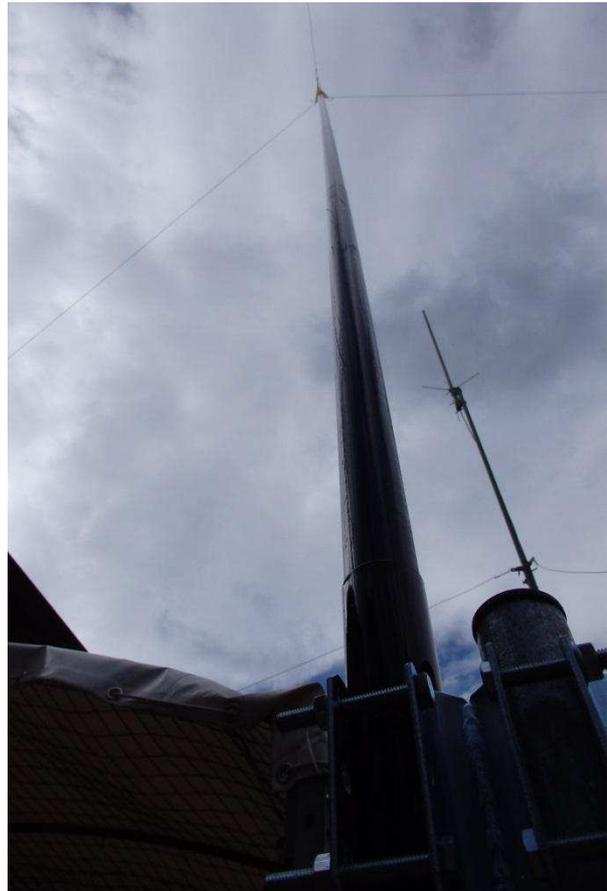
Dopo qualche anno ho voluto sostituire la MaxiWhip di 6 metri con una nuova canna di vetroresina da 10mt. Notare i controventi inseriti a metà antenna tramite una piastra di vetronite, n 3 tiranti, (usato Sagola Dyneema, Sk75, Ø1.5 mm Carico di rottura: 120 kg)
