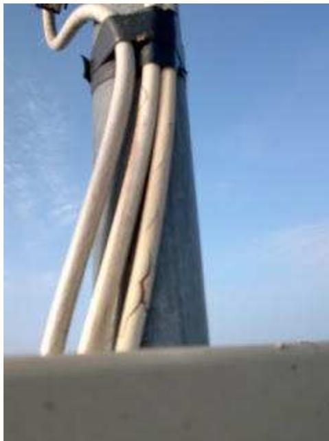
Se la presa è fritta, la si cambia, se il segnale è debole si risale sull'impianto. Troviamo la scatola di derivazione, controlliamo i cavi, se sono quelli con schermatura di rame e vediamo degli aloni verdi, cambiamoli, è probabilmente entrata dell'acqua oppure il posto è umido. In entrambe i casi, i cavi sono da buttare. Optiamo per cavi a doppia schermatura, MAI lesinare sui cavi, specialmente negli impianti d'antenna terrestre o satellitare.
