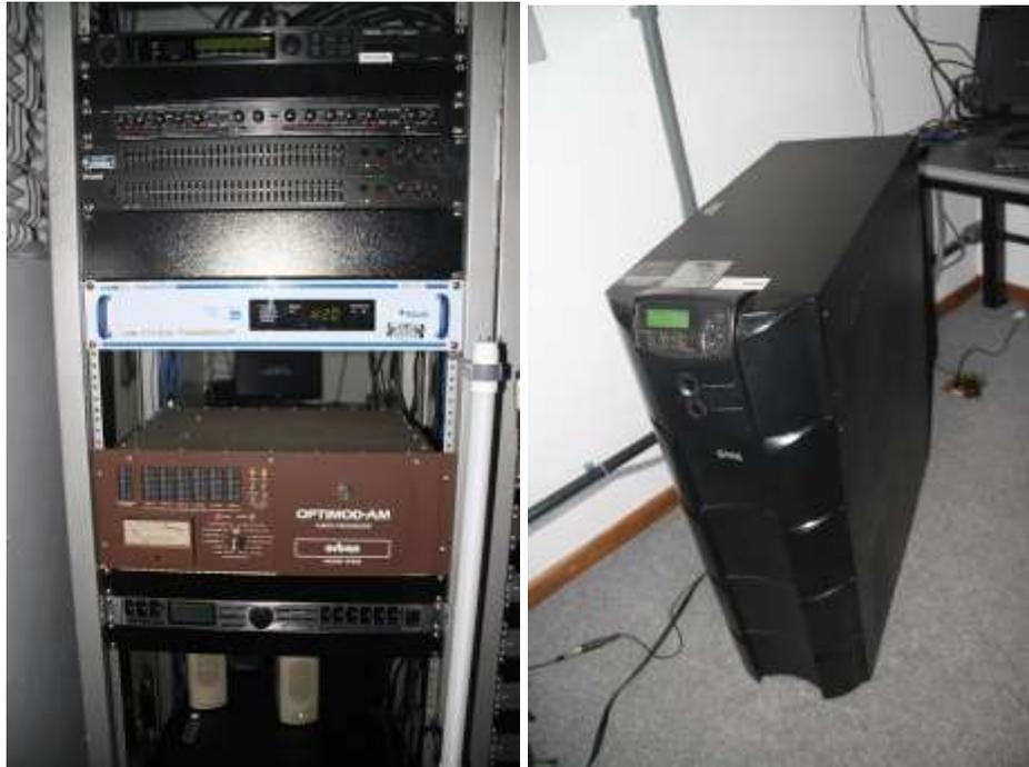
Il mixing rack e la batteria di alimentazione
