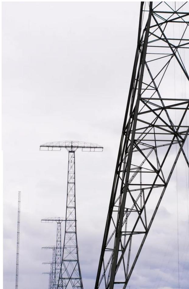
Qui possiamo vedere la grandezza delle torri e delle antenne della stazione radio di Grimeton, ogni torre dell'antenna è alta 127 m e il braccio trasversale è largo 46 m
