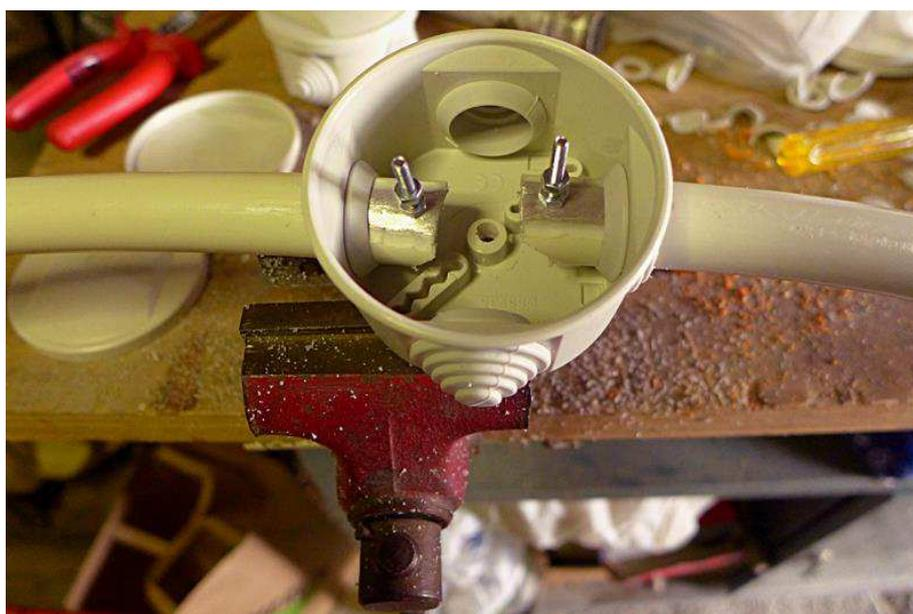
Attenzione, ricordatevi di forare al centro le scatole stagne, come si vede nella foto, con una punta da 6 mm, prima di infilarci dentro le due estremità del tubo, perché dopo sarà impossibile farlo. Questo foro, servirà per fissare le scatole stagne alle loro staffe.
