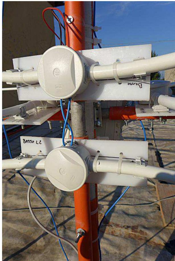
L'antenna è stata montata a questo punto a 3 metri da terra, per effettuare le prove e i collaudi, prima del montaggio definitivo a 7 metri di altezza.
