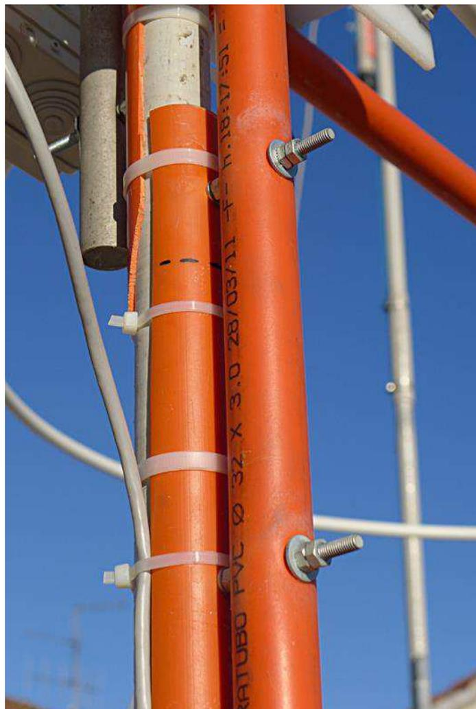
Ho fissato infine con altre fascette, il filo elettrico dei due bracci del Dipolo verticale al Mast, facendo in modo che i due terminali finissero al centro, in corrispondenza del montaggio della scatola contenente i Preamplicatore.
