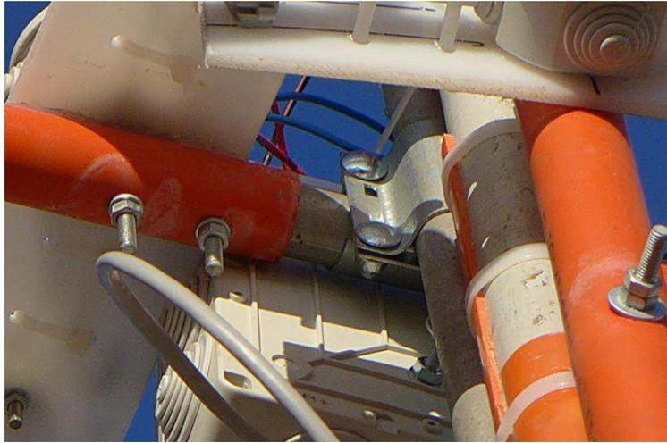
Ho poi tagliato a metà per la sua lunghezza, un altro tubo arancione in PVC, stavolta da 40 mm, e con questi “gusci-conchiglia”, ho fissato il montante dell’antenna Verticale al Mast in vetroresina con tante fasciette robuste, e al tubo verticale arancione in PVC, con diverse viti da 6 mm con bullone e rondelle.
