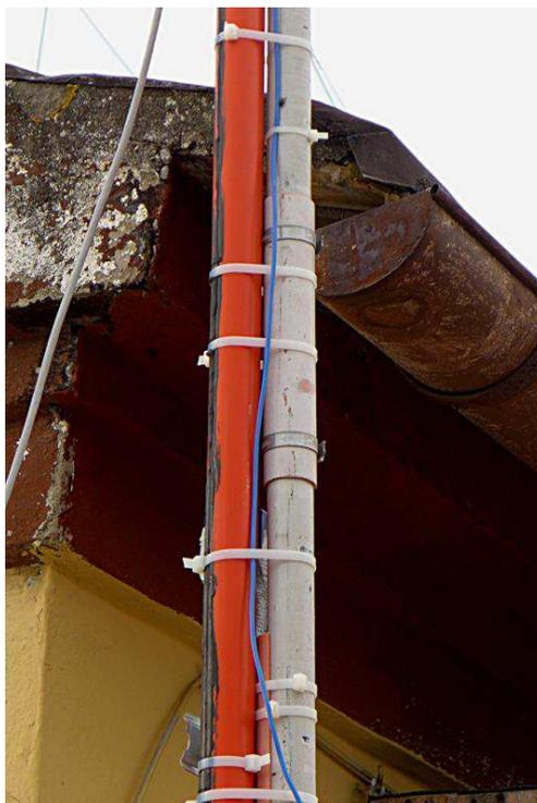
*A destra, il palo in vetroresina con il particolare del giunto con fascette metalliche. A sinistra, il palo di rinforzo in PVC con dentro un robusto palo in faggio, trovato al Leroy Merlin a 18 euro. I due pali sono tenuti insieme da un elevato numero di fascette in plastica.*
