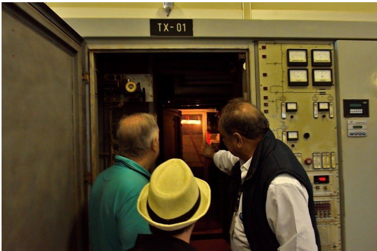
L'ingegnere Ismar Do Vale Junior apre le porte del TX-01 l'imponente trasmettitore a onde corte Brown Boveri & Cie, attivo sulla frequenza di 11.780 kHz
