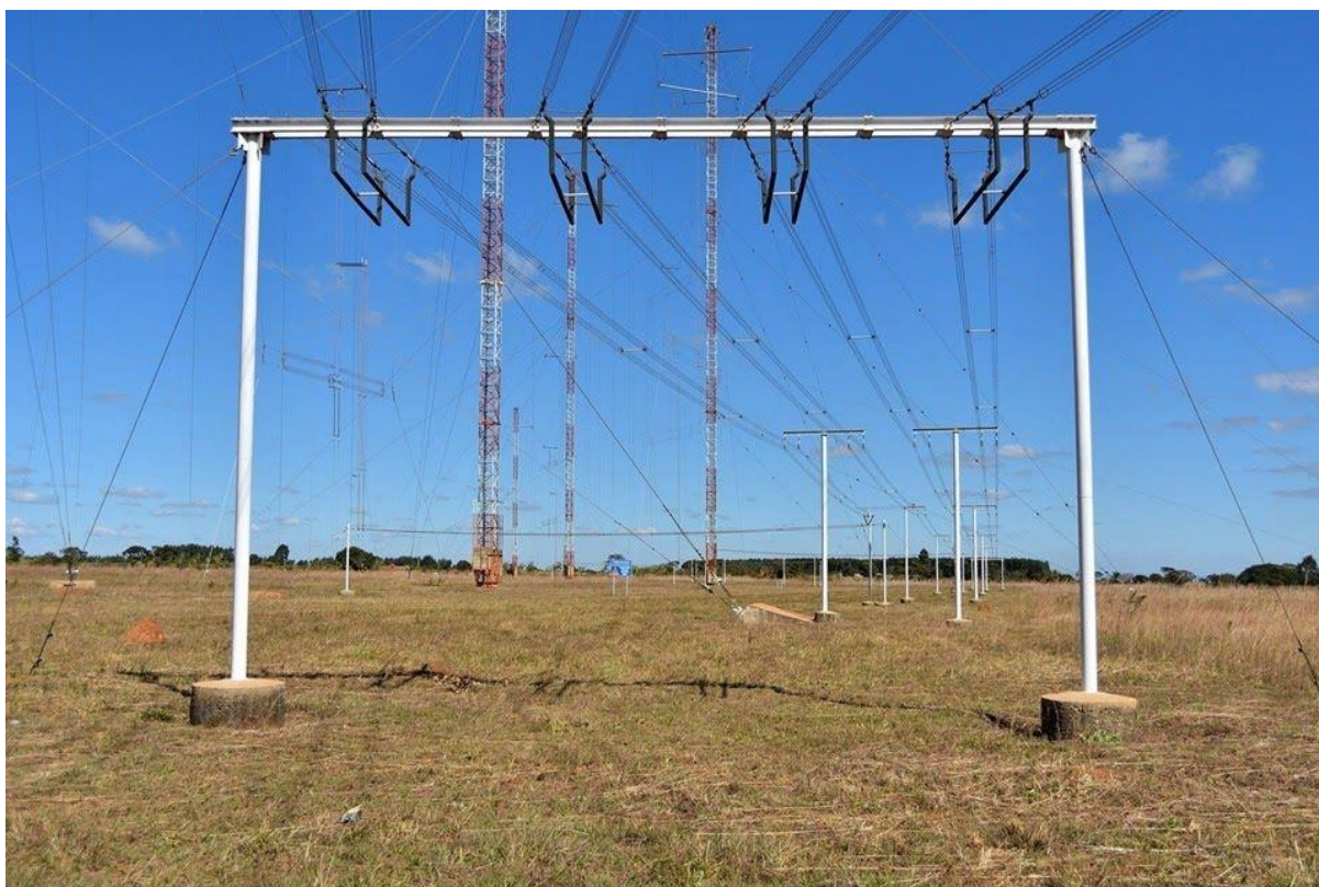
Linee di trasmissione di antenne a onde corte
