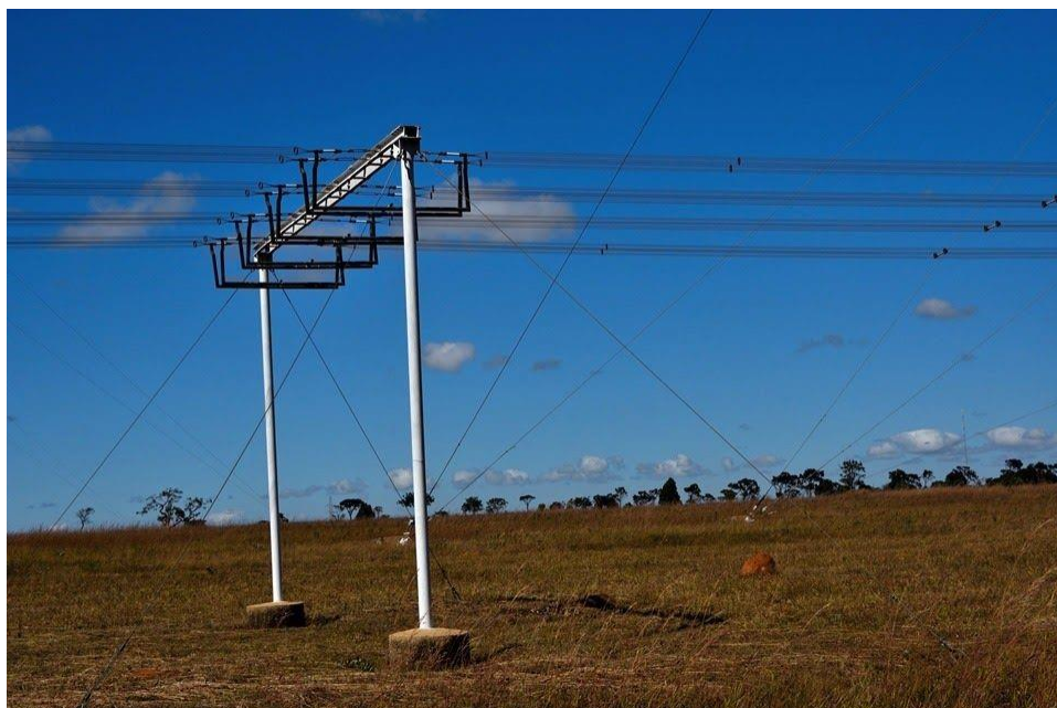
Linee di trasmissione di antenne a onde corte
