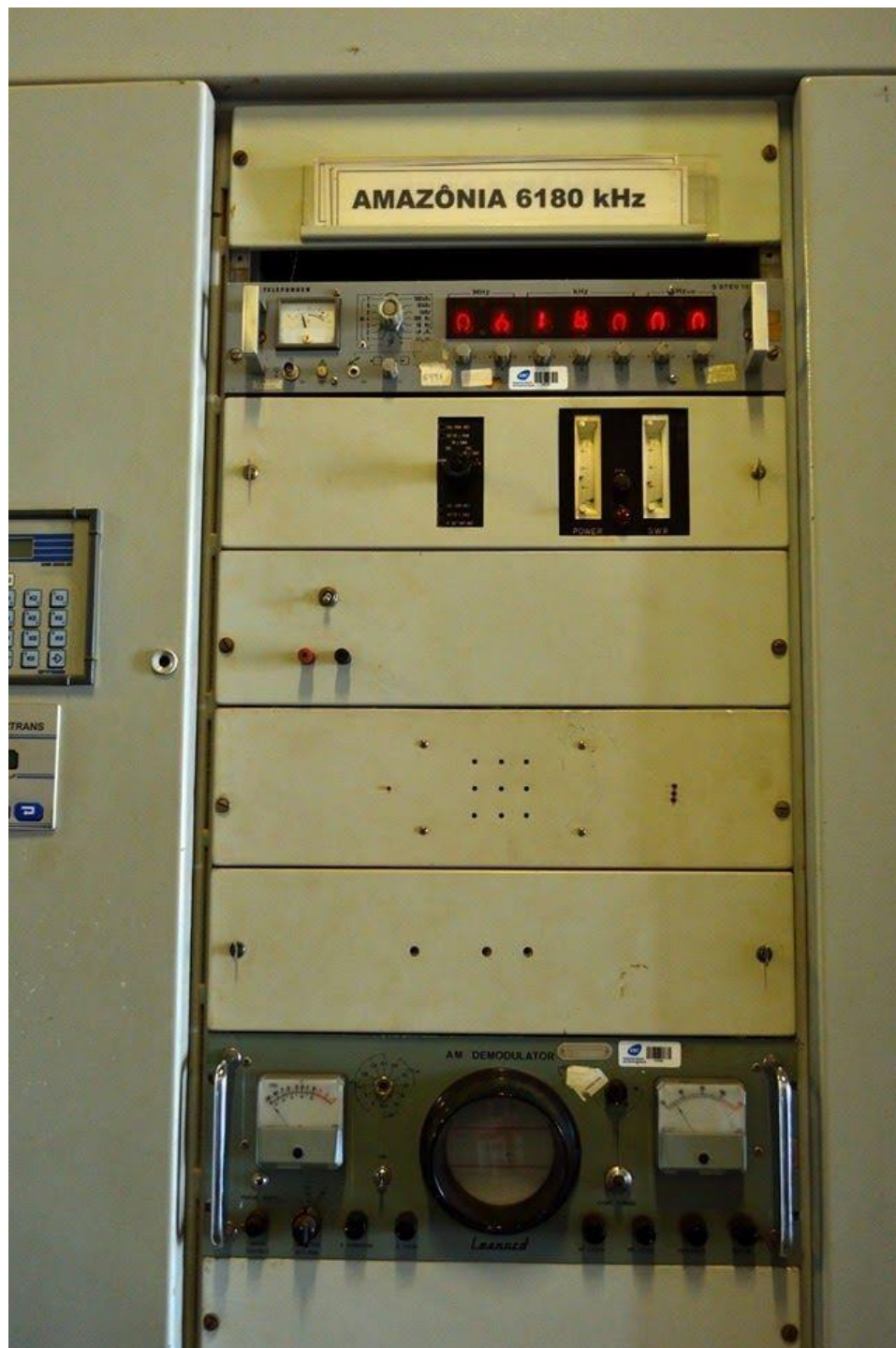
TX-02 l'imponente trasmettitore a onde corte Brown Boveri, attivo sulla frequenza di 6.180 KHz
