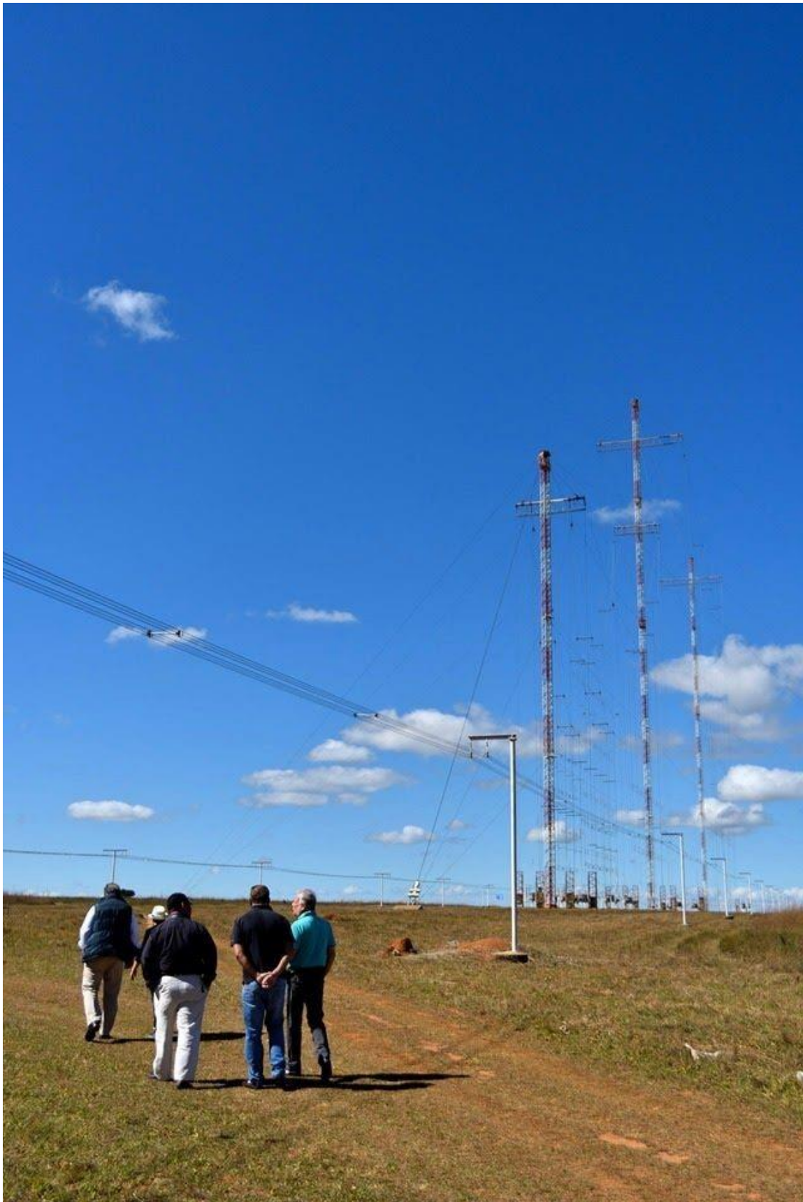
Inizia il tour del parco antenne
