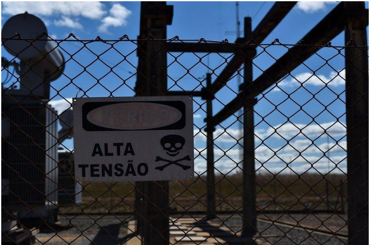
Attenzione, alta tensione !
