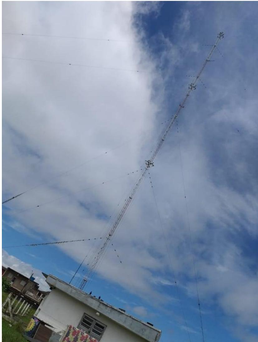
Antenna, monopolo ripiegato alto oltre 60 metri.
