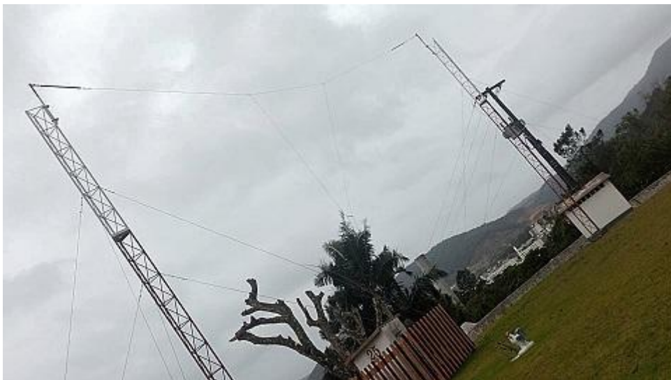
Sistema di antenne rombiche per bande tropicali.
