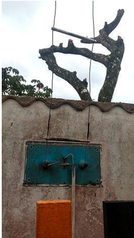
Dettaglio dell'uscita delle linee di trasmissione della scatola dell'accoppiatore
