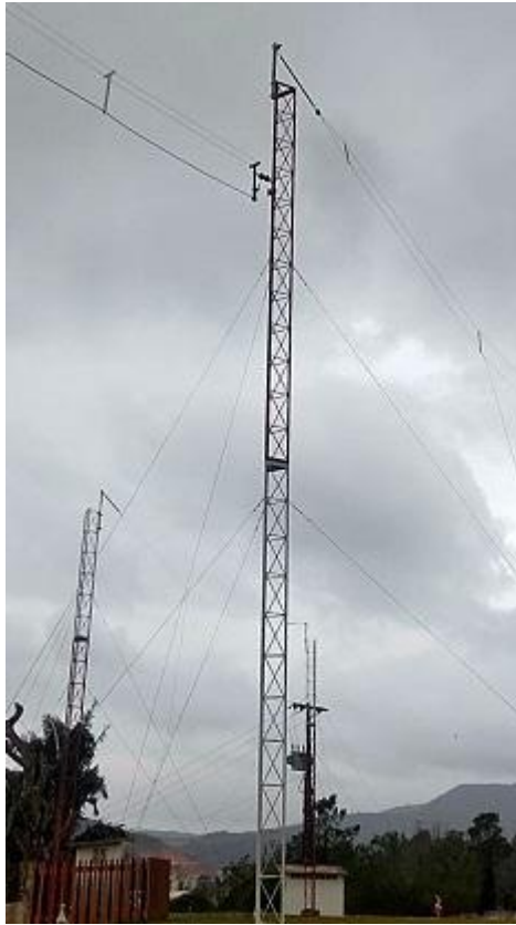
Due antenne Zeppelin utilizzate dall'emittente per diverse bande.
