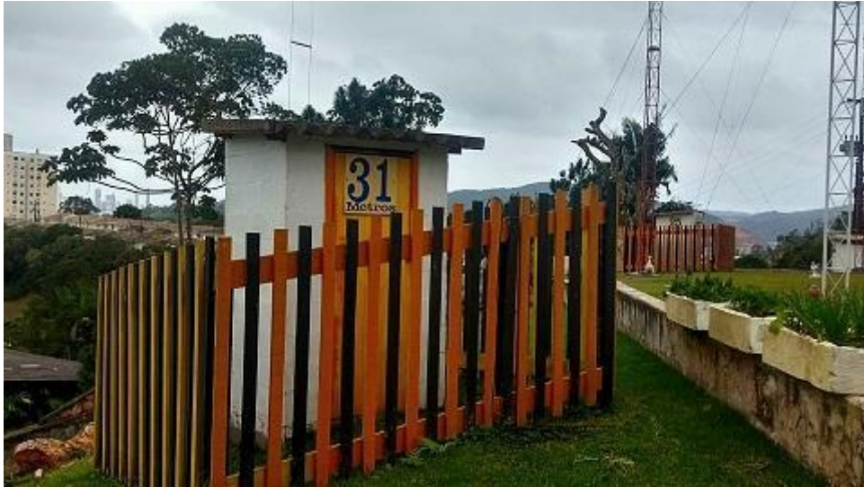
Box dove è alloggiato l'accoppiatore per la banda dei 31m.
