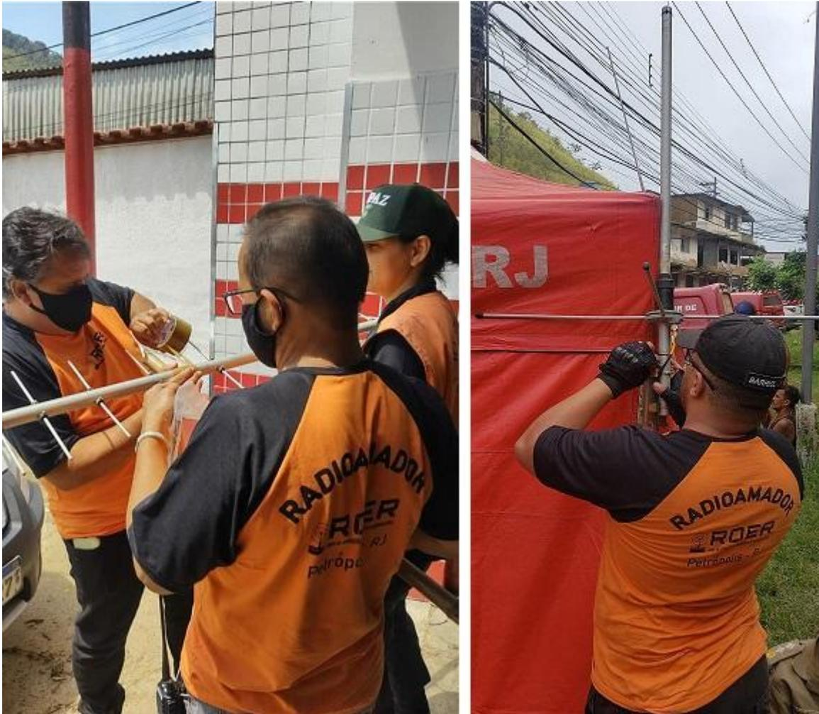
Fotografia 07: Radioamatori appartenenti alla ROER (Rede de Operações de Emergência de Radioamadores), al lavoro sull'installazione di antenne per ponti radio
