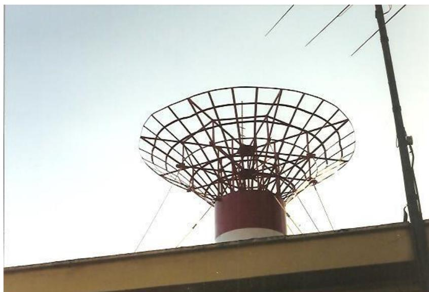
Uno degli impianti RAI dismessi anni fa, la famosa antenna CFA di Sanremo (IM) del 2000, frequenza 1188kHz con 6 kW. (foto BP)
