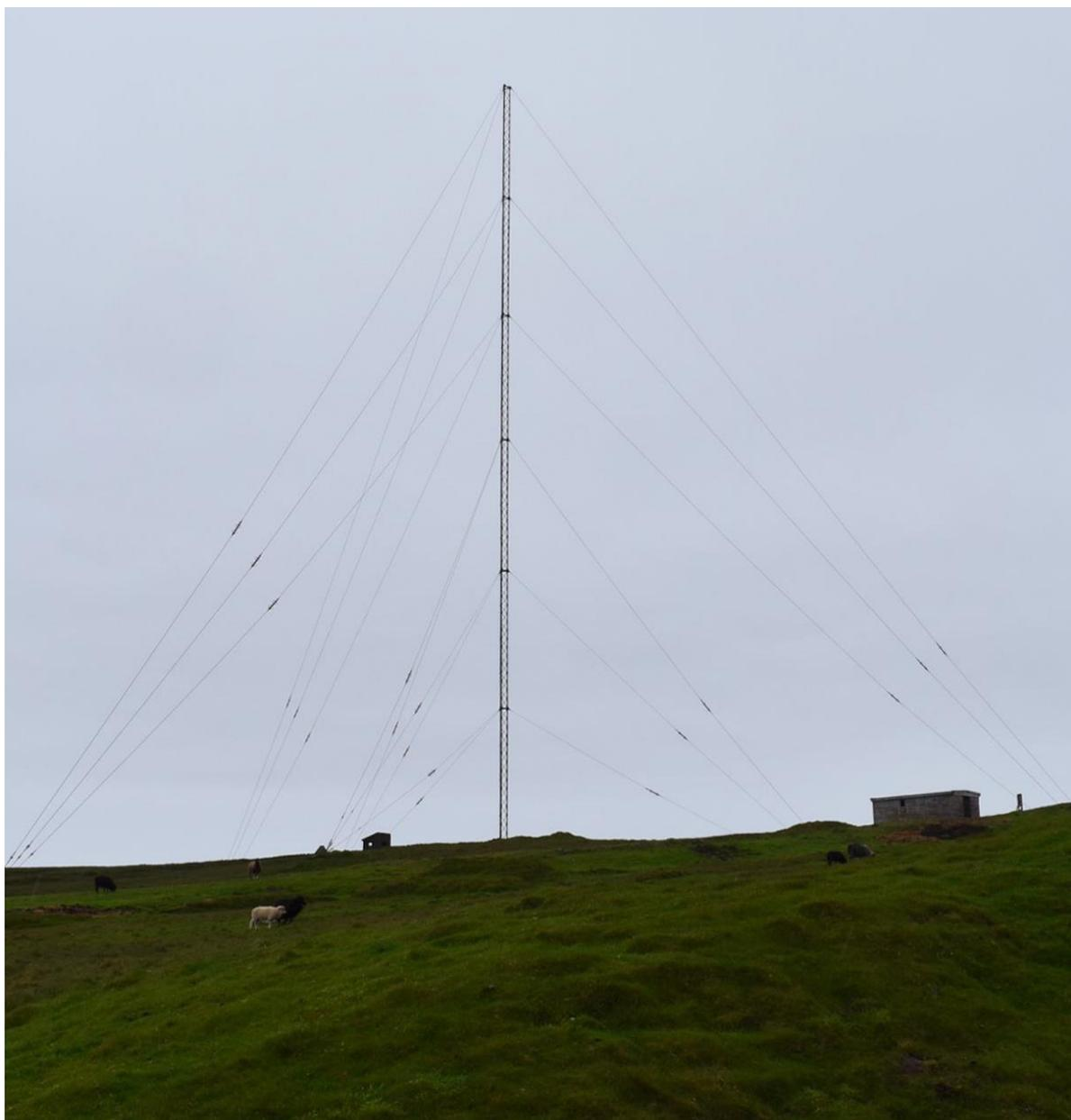
*L'antenna di 141 m ad Akraberg utilizzata per irradiare KVF su 531 kHz
