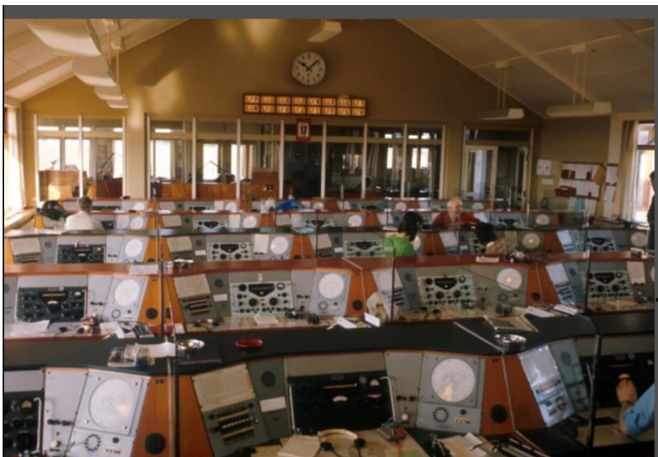
Stazione radio costiera di ROGALAND RADIO (Norvegia anni 70/80), notare i ricevitori RACAL RA17L e i Collins 51-J4 entrambe per AM/SSB/CW
